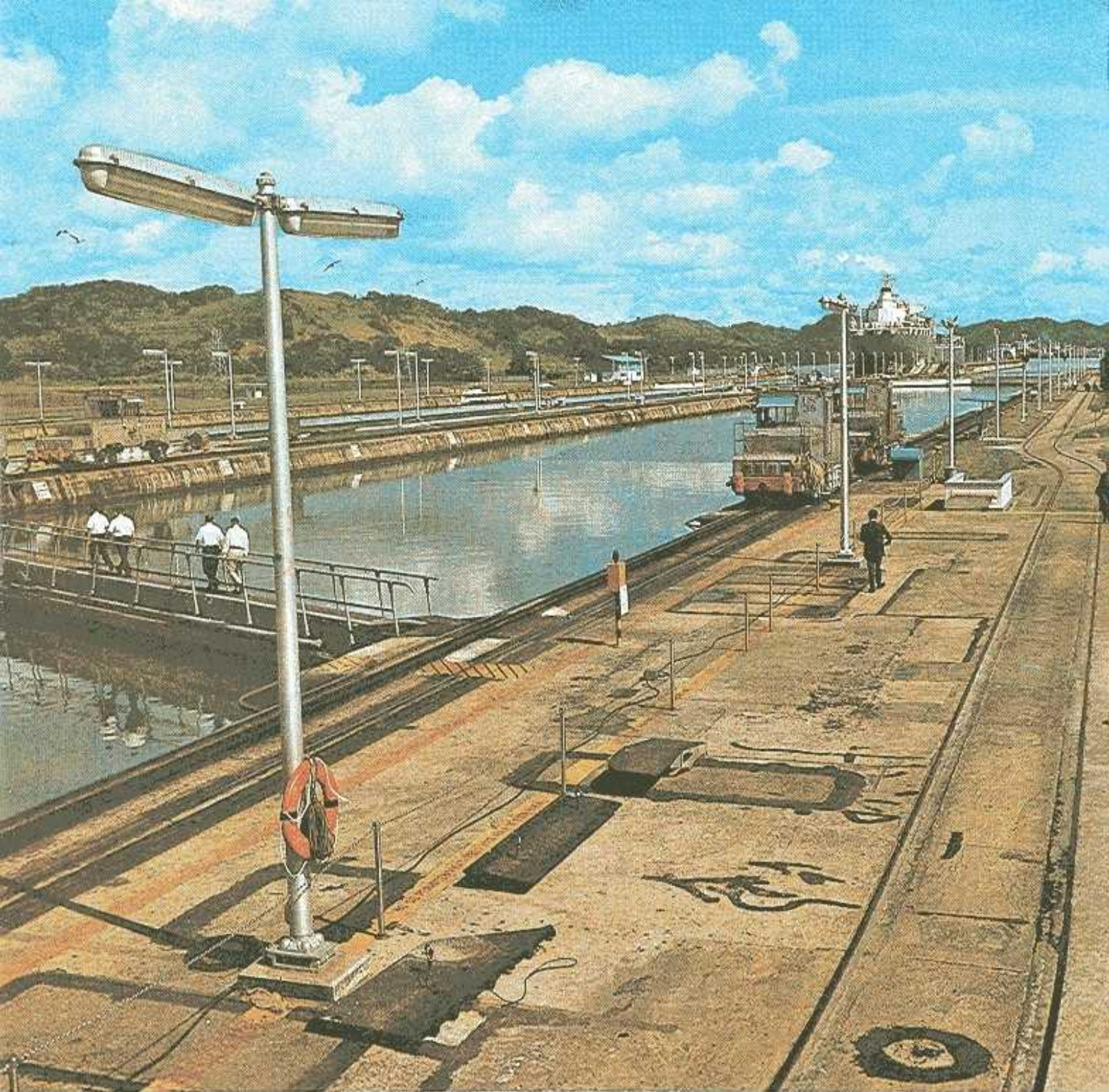
Un aspecto del Canal en las Esclusas de Miraflores.
