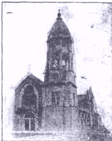
Templo de San Fco. reconstruído.
