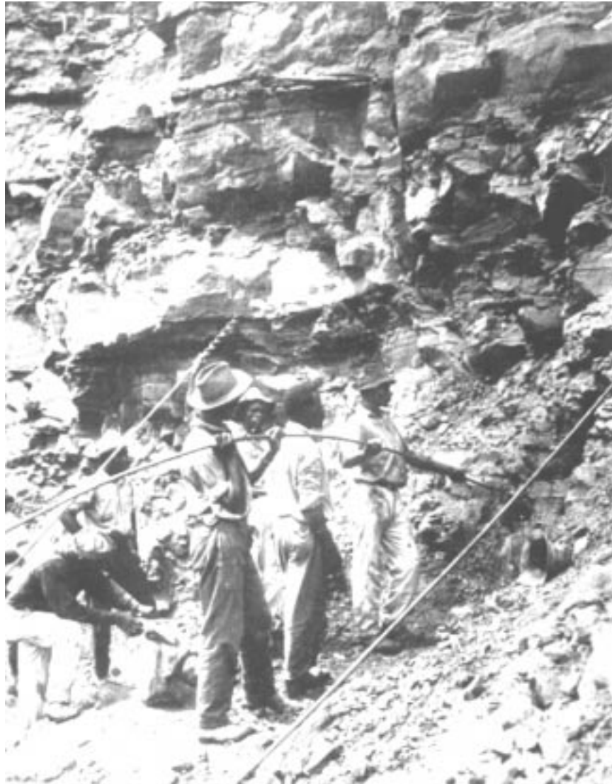
Vista No. 2 muestra una cuadrilla de perforadores taladrando huecos para colocar cargas de dinamita en un costado del Corte Culebra. Febrero de 1912.
