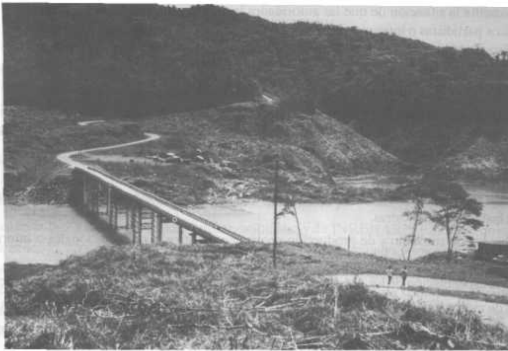
Vista del puente de la carretera del oleoducto Chiriquí - Bocas del Toro, sobre el embalse de la hidroeléctrica de La Fortuna.
